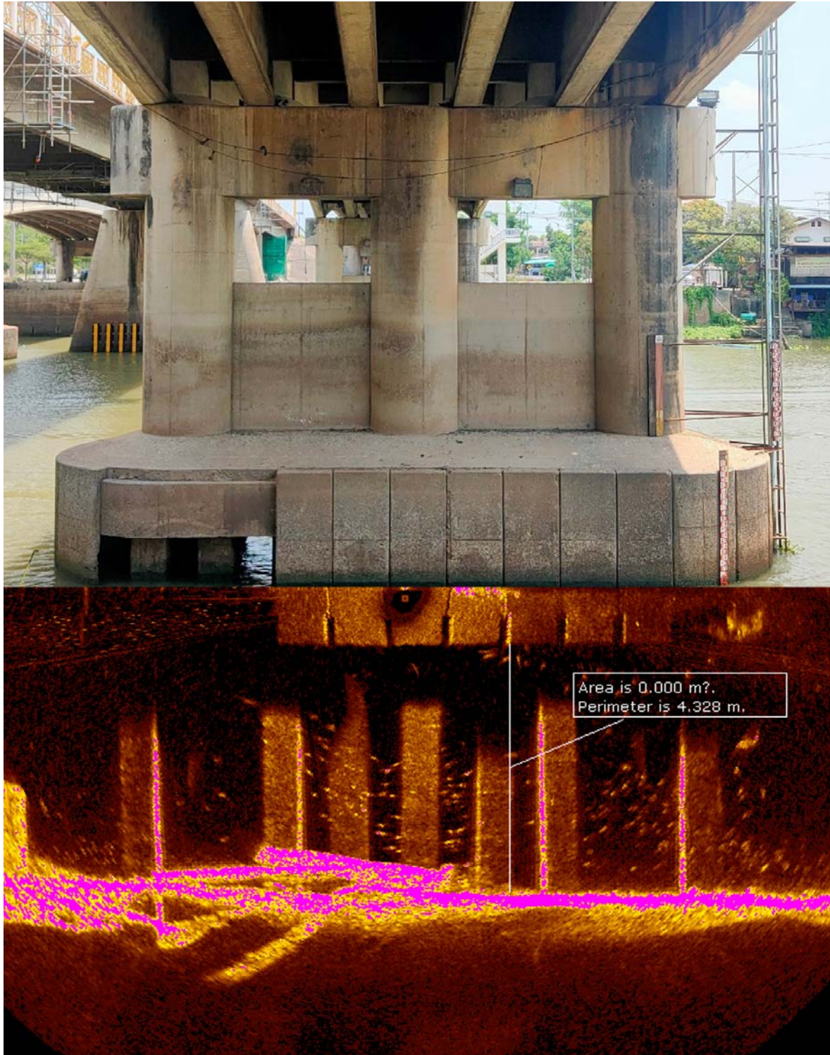
รูปที่ 4-14 ผลการสำรวจสภาพโครงสร้างใต้น้ำตอม่อ P4 สะพานสมเด็จพระนเรศวร ด้าน อยุรยา
