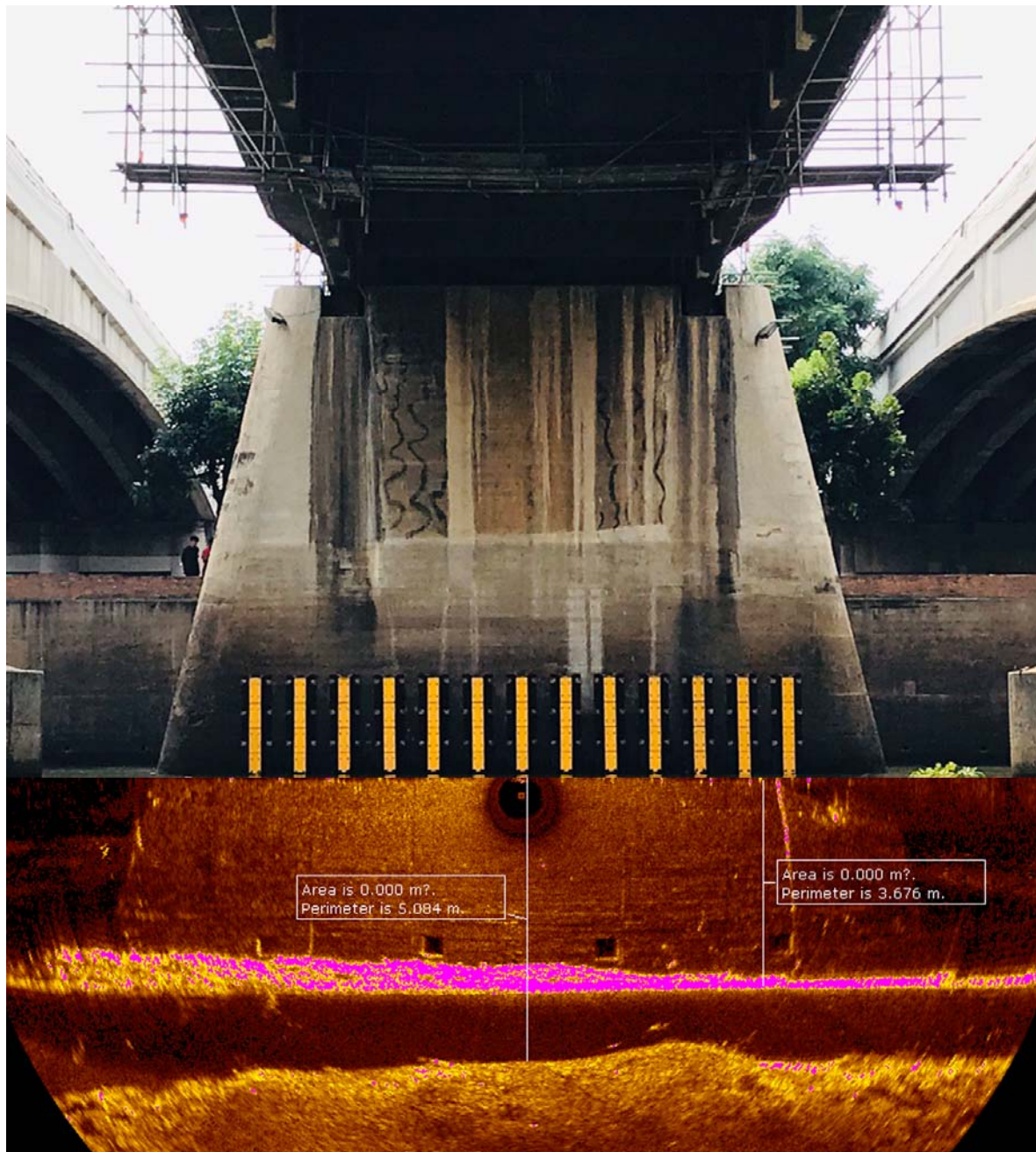
รูปที่ 4-9 ผลการสำรวจสภาพโครงสร้างใต้น้ำตอม่อ P4 สะพานปรีดี-ช้าง ด้าน วังน้อย
