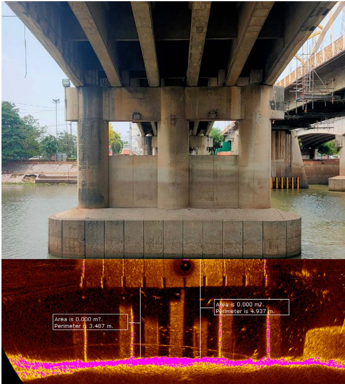
รูปที่ 4-11 ผลการสำรวจสภาพโครงสร้างใต้น้ำตอม่อ P3 สะพานสมเด็จพระนเรศวร ด้าน วังน้อย
