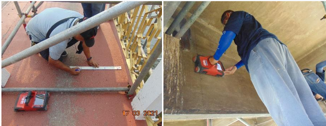
รูปที่ 5-6 ขั้นตอนลักษณะการสแกนในโครงสร้างด้วยเครื่องมือ Ground Penetrating Radar
