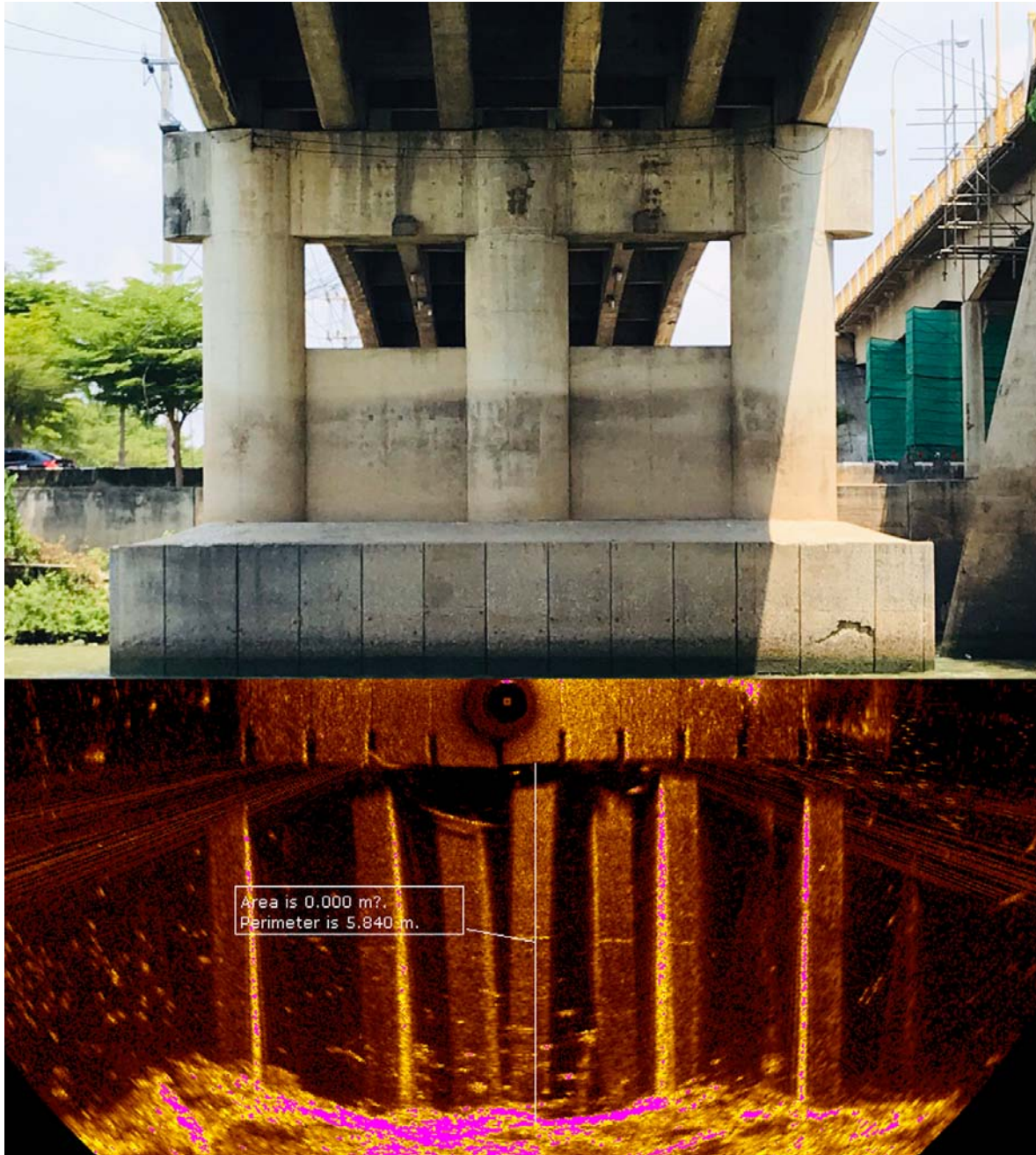
รูปที่ 4-16 ผลการสำรวจสภาพโครงสร้างใต้น้ำตอม่อ P3 สะพานสมเด็จพระเอกาทศรถ ด้าน อยุรยา
