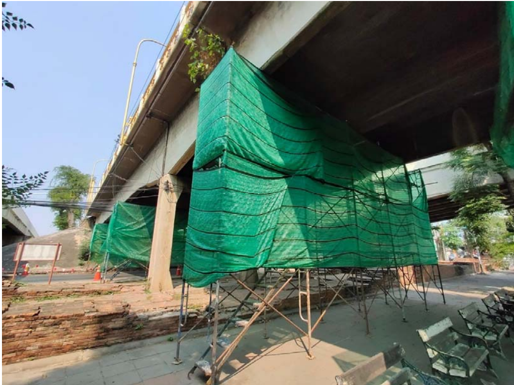
รูปที่ 2-12 การตั้งนั่งร้านสำหรับการตรวจวัดมิติของสะพาน
