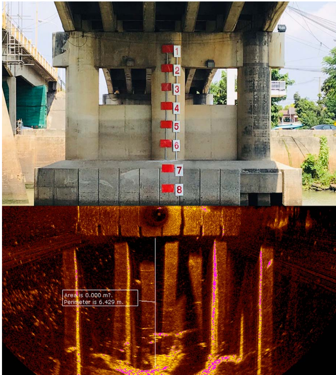
รูปที่ 4-12 ผลการสำรวจสภาพโครงสร้างใต้น้ำตอม่อ P3 สะพานสมเด็จพระนเรศวร ด้าน อยุรยา
