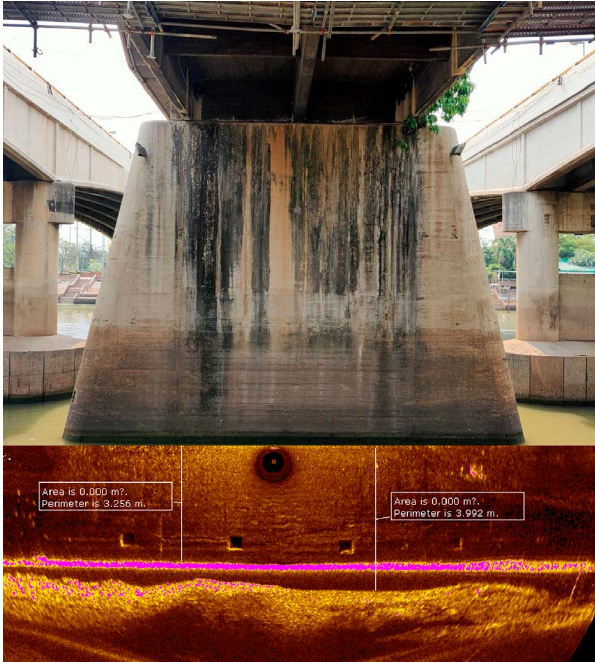
รูปที่ 4-7 ผลการสำรวจสภาพโครงสร้างใต้น้ำตอม่อ P3 สะพานปรีดี-ช้าง ด้าน วังน้อย
